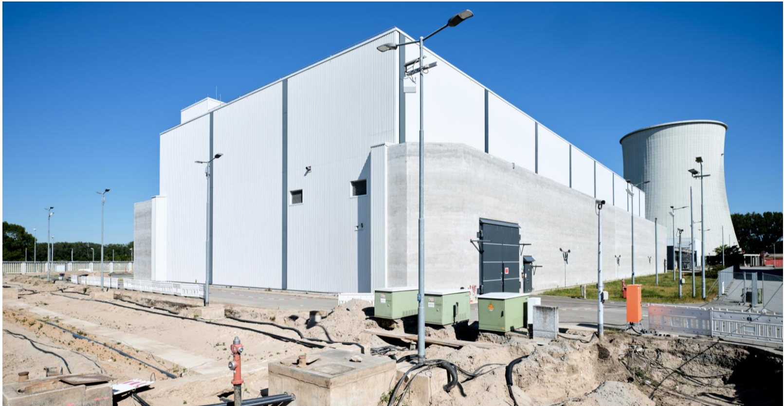
Aufnahme der Baustelle im Bereich des BZB (05/2021)
